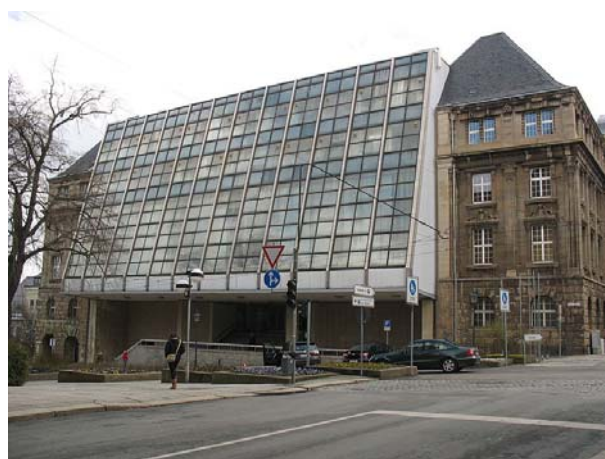
die 1976 eingeweihte Glasfassade des Neuen Rathauses
